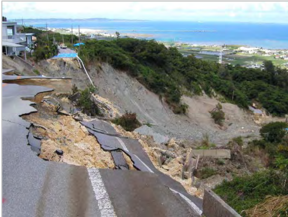
（地すべり直後の状況）
